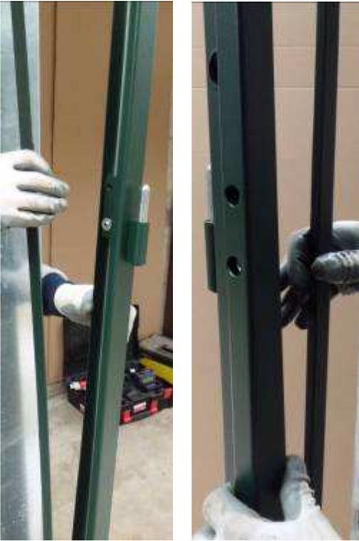
Mediante la chiave a brugola da 5 mm. azionare tutti gli appositi espansori per fare aderire il Telaio e i Profili compensatori perfettamente alla parete.
