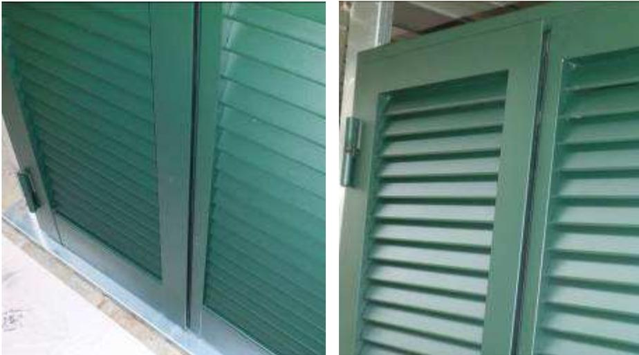
Allentare le viti di fissaggio e staccare il Telaio nei punti dove il fuori squadra della parete non permette di fare lavorare il Telaio perfettamente in squadra. (vedi esempio nelle foto)
