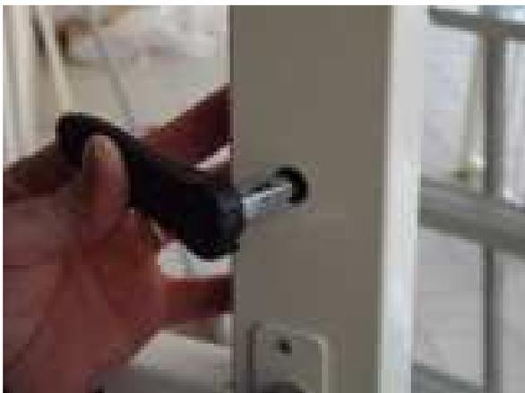
Inserire la maniglia nella serratura e fissarla con chiave a brugola da 4 mm.; ruotare la serratura per estrarre i deviatori di chiusura e verificare l'allineamento con le asole del telaio.
