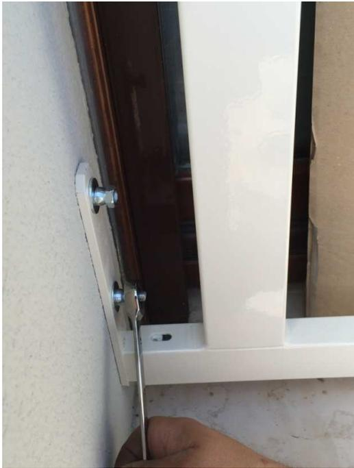
Applicare le rondelle di spessoramento e le teste in Acciaio Antirimozione; avvitare con chiave esagonale da 13 mm (consigliata a cricchetto) con forza fino a “strappare” l’inserto esagonale. Nel caso in cui vi sia sporgenza della barra filettata questa potrà essere rimossa, FACENDO MOLTA ATTENZIONE A NON ENTRARE IN CONTATTO CON NESSUNA PARTE DELLA GRATA, mediante utensile da taglio (sega a mano o flex)
