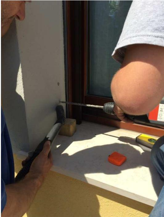
In caso di muro pieno forare con trapano e punta da 10 mm. in caso di termocappotto la punta dovrà essere più grande rispetto la dimensione della calza utilizzata.
