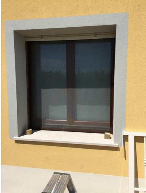
Inserire le 4 staffe di fissaggio nei traversi SUPERIORE e INFERIORE della grata. Posizionare la grata nel foro muro appoggiandola su due spessori di 60 mm precedentemente collocati sulla soglia; questi ultimi ci permetteranno di centrare verticalmente la grata.
