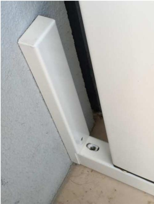
Inserire le COVER di finitura e copertura dei sistemi di fissaggio.
