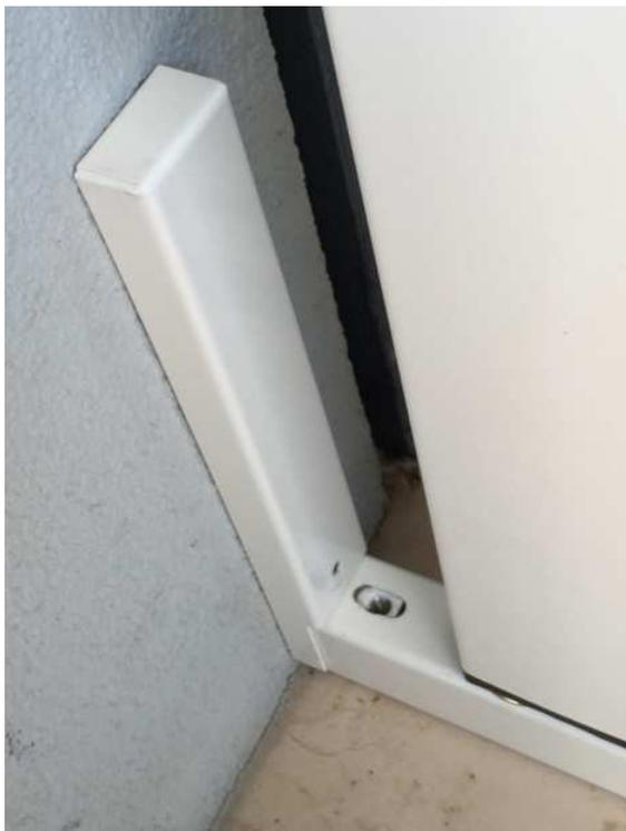
Inserire le COVER di finitura e copertura sistema di fissaggio.
