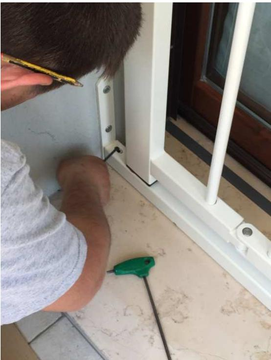
Una volta allineate le ante, bloccare i grani inseriti nelle scarpette superiori e inferiori; con questa operazione si potranno eliminare anche le minime tolleranze di fuorisquadro muro.
