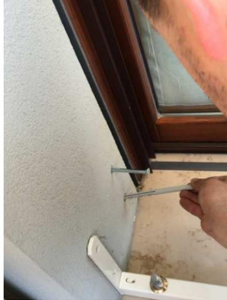
Fissare a muro il telaio a pavimento mediante le scarpette laterali.
