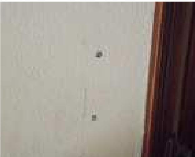
Segnare a muro i punti di fissaggio.
